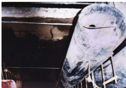
Рисунок 13 – Монтаж пустообразователей
