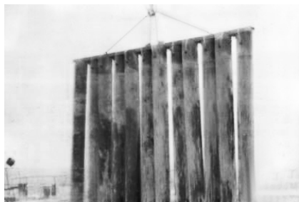
Рисунок 12 – Подача пустообразователей краном с применением траверсы
