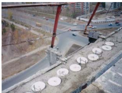
Рисунок 12 – Подача пустообразователей краном с применением траверсы
